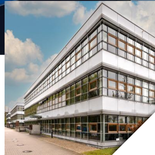
Hunkeler Deutschland GmbH Aschheim, Deutschland
